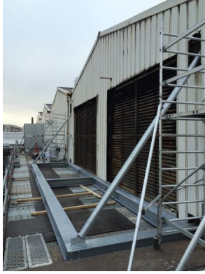
Mise en place de 2 structures métalliques : 2 x 2T pour supporter les silencieux.
